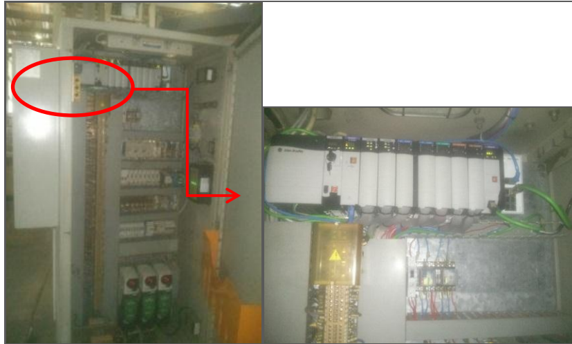
Figura 16. Ubicación del cableado de comunicación en tableros de empaquetadoras. Fuente: Elaboracion propia (2016)
