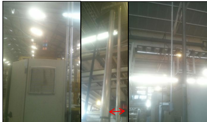
Figura 13. Ruteo de tuberías de cableado de comunicación a equipos Fuente: Elaboración propia (2016)
